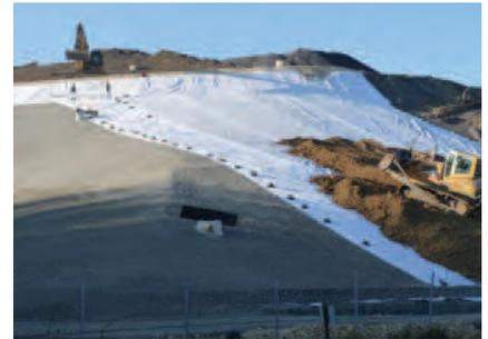
in den Deponiekörper eindringen und kein Deponiegas unkontrolliert durch die Oberfläche entweichen kann. Ausgeführt wurde ein Abdichtungssystem bestehend aus einer 2,5 mm starken Kunststoffdichtungsbahn und einer Dichtungsmatte aus mineralischem Material (geosynthetische Tondichtungsbahn). Darüber und darunter liegende Entwässerungsschichten ergänzen
